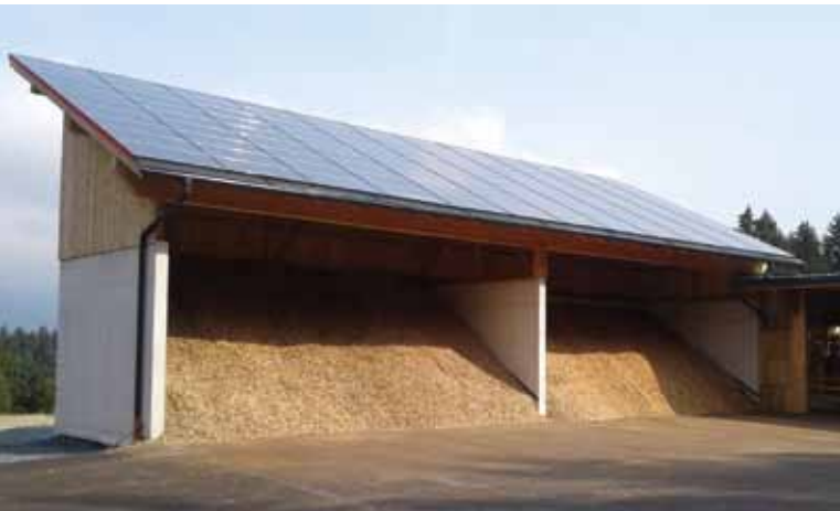
Ansicht der 219 m 2 großen Luftkollektoranlage am Dach der beiden Hackgutrocknungskammern
