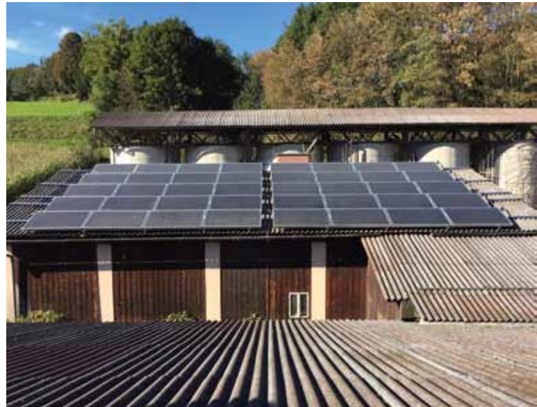
Ansicht der 102 m 2 großen Kollektorfläche am Dach des Betriebsgebäudes „Staa Hof“
