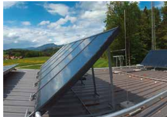
Gesamtansicht Produktionsbetrieb Weizer Schafbauern (oben); am Flachdach aufgeständerte Solarkollektoren (unten)
